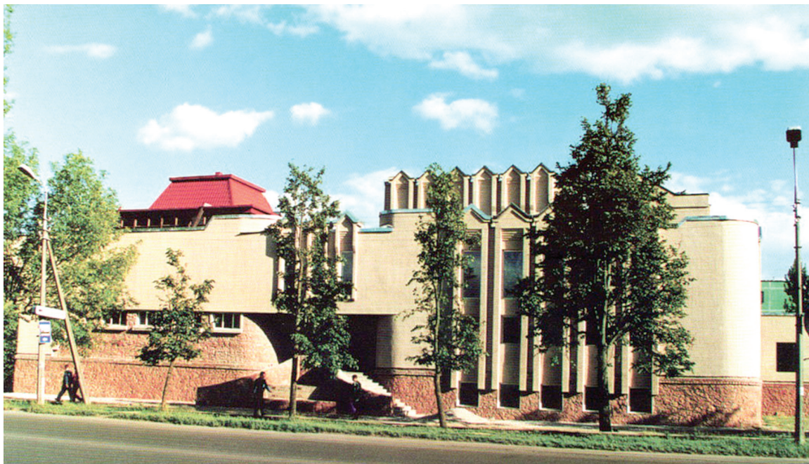
Бывший недостроенный Дом природы, ныне здание Газпром ПсковРегионГаз. Псков, Рижский проспект, д. 20, 1999 год. Фото: М.А. Холод, И.И. Лагунин, Т.Н. Данилова.
