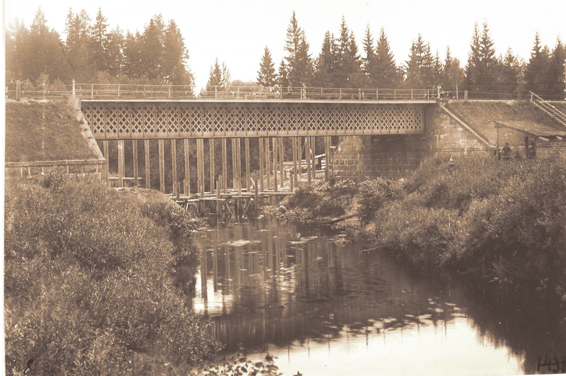
Псковская губерния. Между Торошино и Псковом. Вид железнодорожного моста через Пскову на 245-й версте. Фото из альбома интернет-пользователя humus777: «Петербург-Варшавская железная дорога. Часть 2. Из Псковской в Виленскую губернию».
