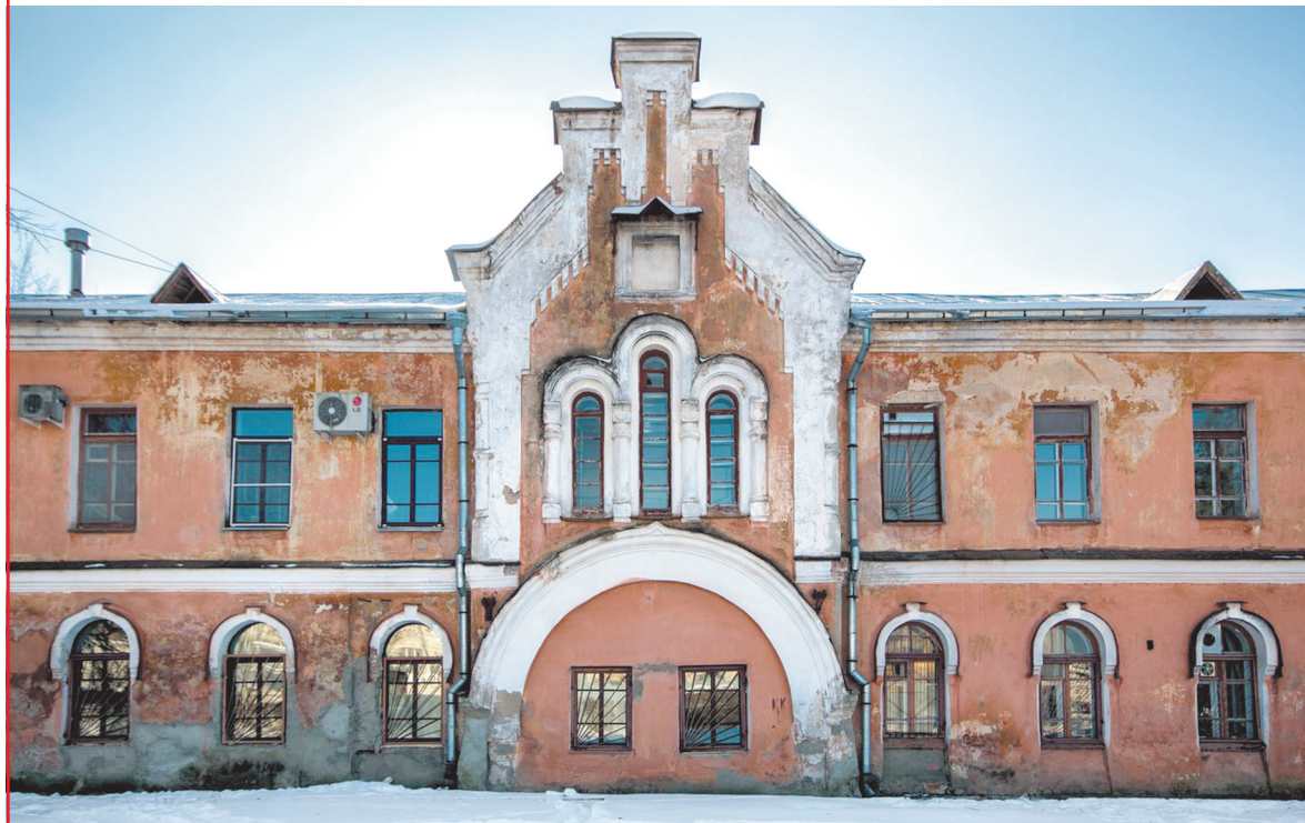
Здание Печерского подворья (надвратный корпус) г. Псков, ул. Профсоюзная, д. 10
