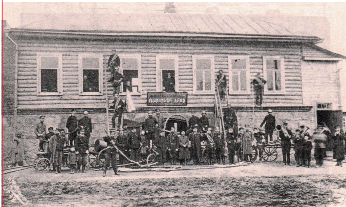
Пожарное депо построено в 1894 году. Бежаницы, Псковская область. Фото 1908 года.
