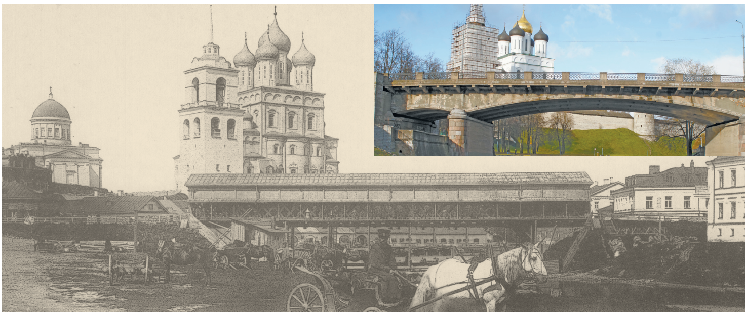
Деревянный крытый мост через реку Пскову у Рыбных рядов.
